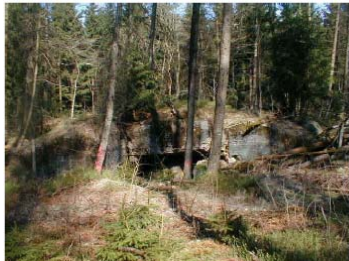
Abb. 5: Ein gesprengter Bunker mit noch gut erhaltener Decke. Das Bauwerk ist zum Teil zugänglich. Vorgelagert sind die Verbindungsgräben mit Schützenstellungen deutlich erkennbar.
